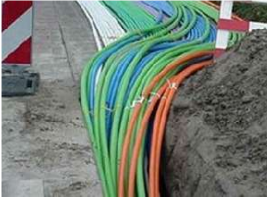
Figuur 5.15: Mantelbuizen worden samen in een kabelbed gelegd. Het model maakt de verwijzing tussen kabelbed en de daarin liggende mantelbuizen of kabels en leidingen mogelijk.
